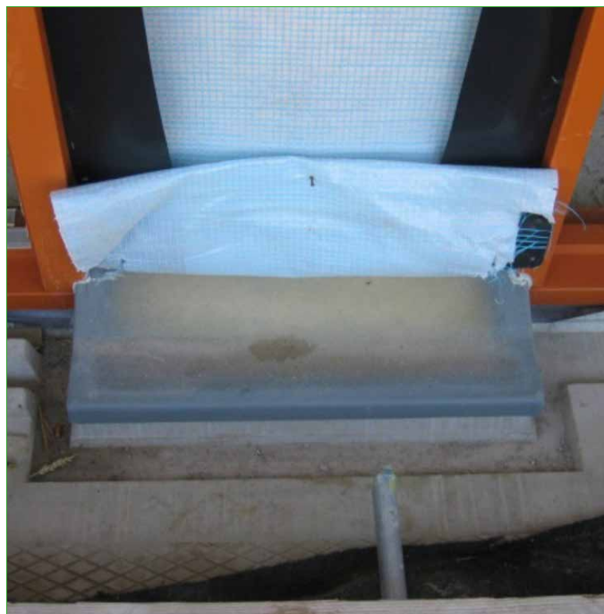
Geplaatste LV penant element
