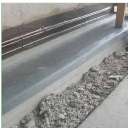
Geplaatst en luchtdicht afgeplakt
